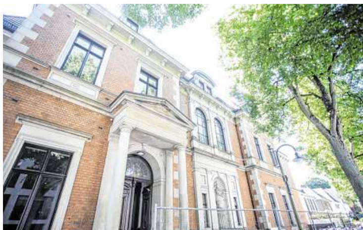
Die Villa Fritze von der Straßenseite. An der Fassade ist nichts verändert worden. So wollte es der Denkmalschutz. Eingerüstet war das Gebäude aber trotzdem. Alle Fenster wurden aufgearbeitet und neu gestrichen – in der alten Farbe.
